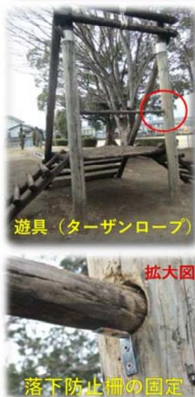
黒石公園の遊具「ターザンロープ」のスタート台からの落下防止柵（丸太棒）が抜け落ちて、子どもたちの落下の危険がありました。ラウンドゴルフの会員が仮止めし直ちに市へ要望しました。その後直ぐに市がJ型金具で固定しました（写真）。これで遊びの安全が確保できると思われます。
