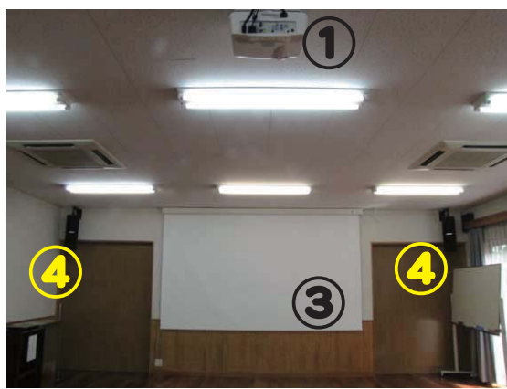
⑤⑥ブルーレイレコーダー・AVアンプ ①プロジェクター③スクリーン④フロントスピーカー
