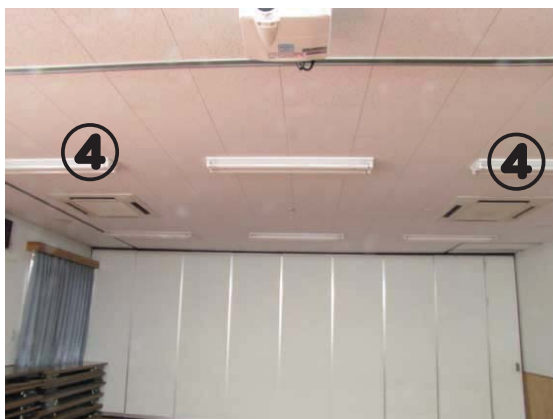
④天井埋込型リアスピーカー
