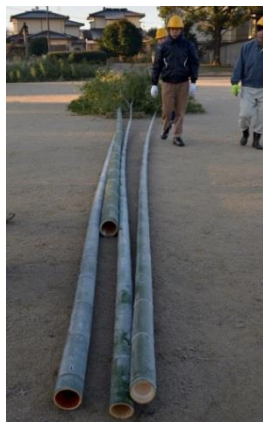
芯柱と3本の支え （芯柱は支え竹より 約1.5m 短くカット）
