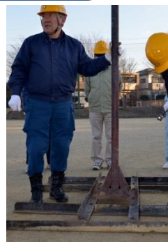
③芯棒を載せ、ボルトで締め付ける。
