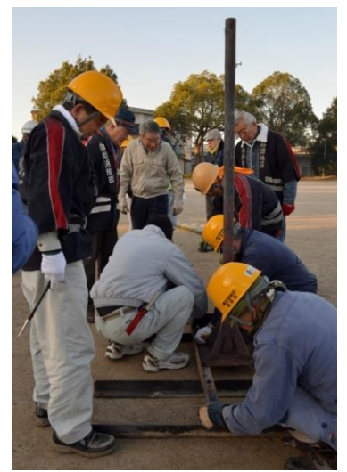
③芯棒を載せ、ボルトで締め付ける。
