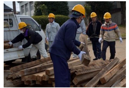
角材「芯柱の周囲に櫓を組む」 （同じ長さにカットしておく）
